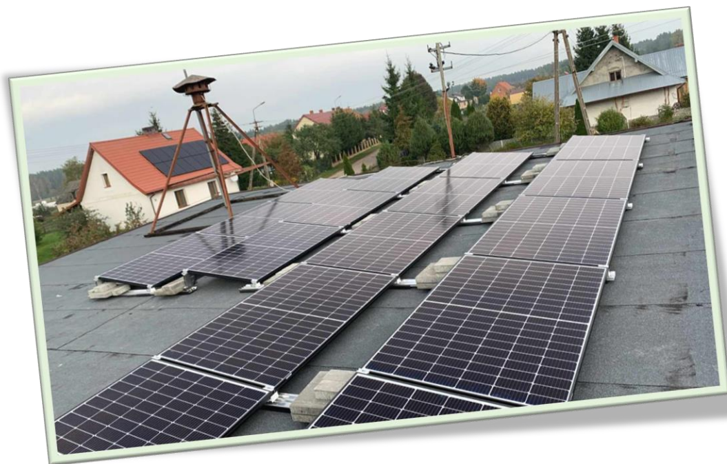
Fot. Dachowa mikroinstalacja fotowoltaiczna
