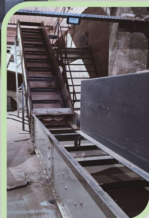
Fot. Kotłownia K-1 – Zasobnik zrębki z układem hydraulicznego wygarniania oraz nowy transporter zrębki typu redler
