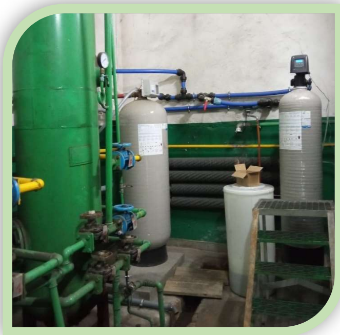
Fot. Nowa stacja uzdatniania wody kotłowni K-4 Bemowo Piskie
